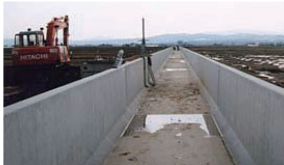
北海道 (国附かん排深川第2地区21工区)
