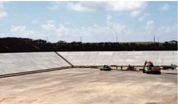
沖縄県 (波照間地区貯水池建設工事)
