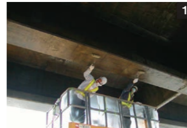
プライマー塗布
