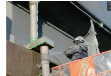
CVスプレー吹付け
