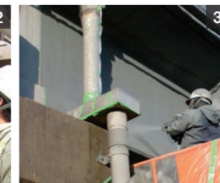
CVスプレー吹付け
