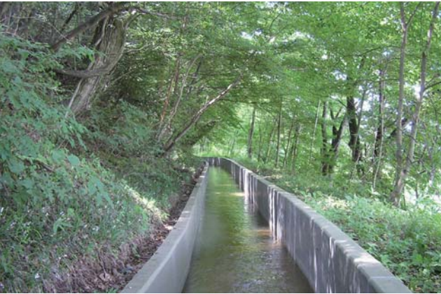
農業施設（開水路）
