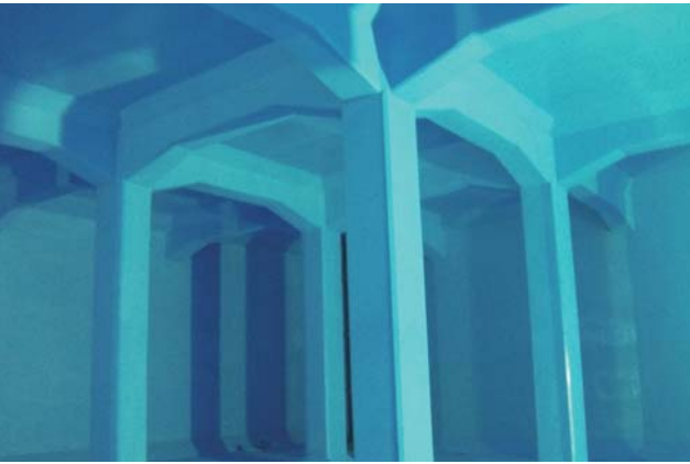
上水施設（配水池）
