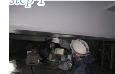
プライマー塗布
