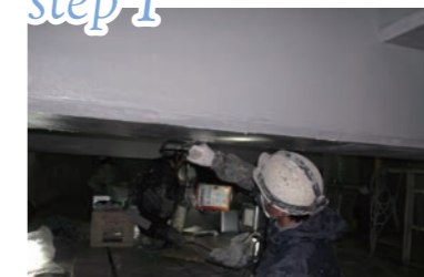
プライマー塗布
