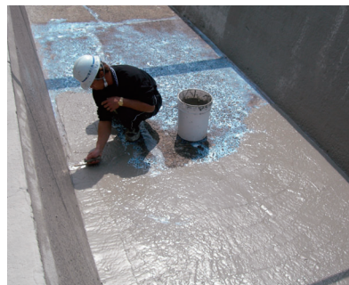
素地調整材塗布 ※オプション（下地状況により省く事が出来ます）
