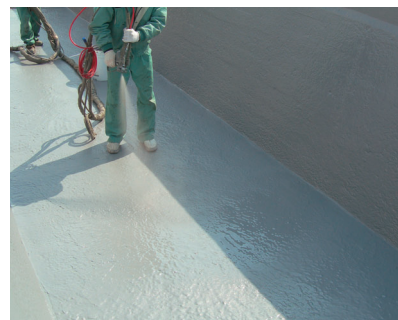
CVスプレー塗布工
