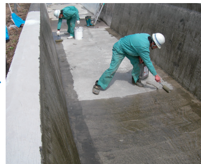
プライマー塗布
