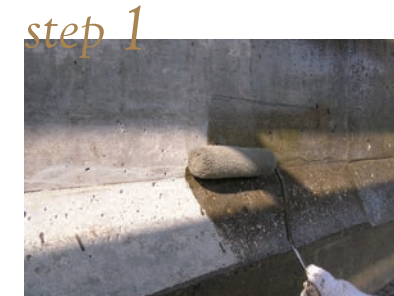
プライマー塗布
