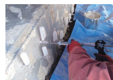
橋台ひび割れ注入
