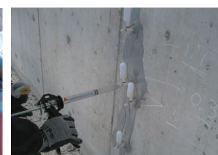
橋脚ひび割れ注入
