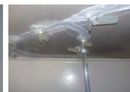
床版ひび割れ注入
