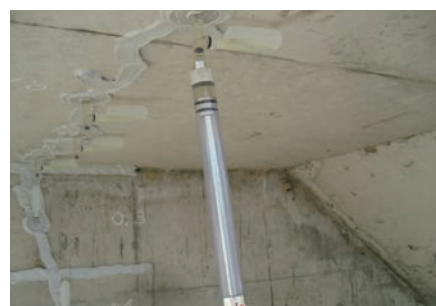
コンクリート打放し・上裏面
