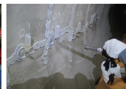
地下ビットひび割れ注入
