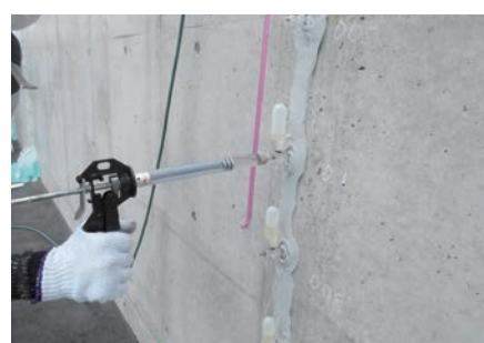
コンクリート打放し面
