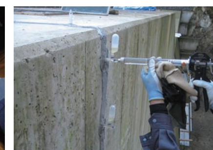
砂防堰堤ひび割れ注入
