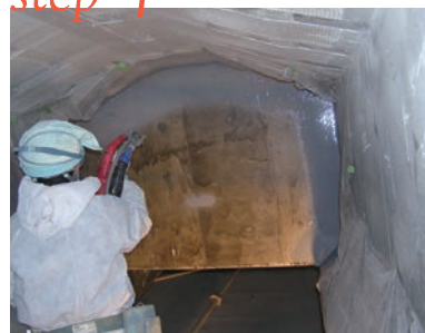
超速硬化ウレタン吹付け
