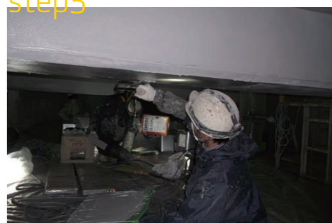
プライマー塗布
