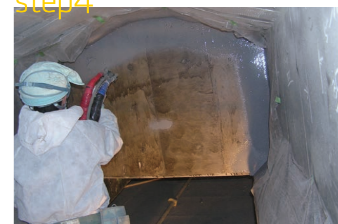
超速硬化ウレタン吹付け
