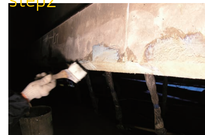
下地処理 (断面修復)
