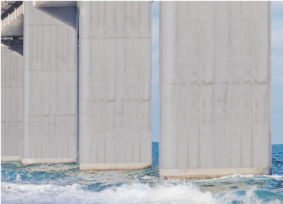
橋脚 長寿命化対策
