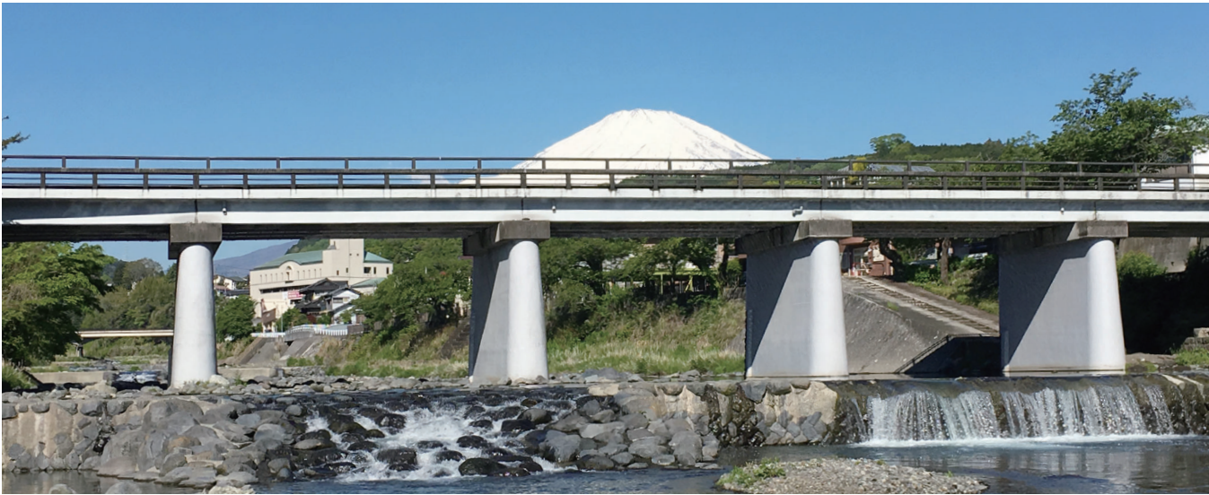
橋脚補修工事 長寿命化対策
