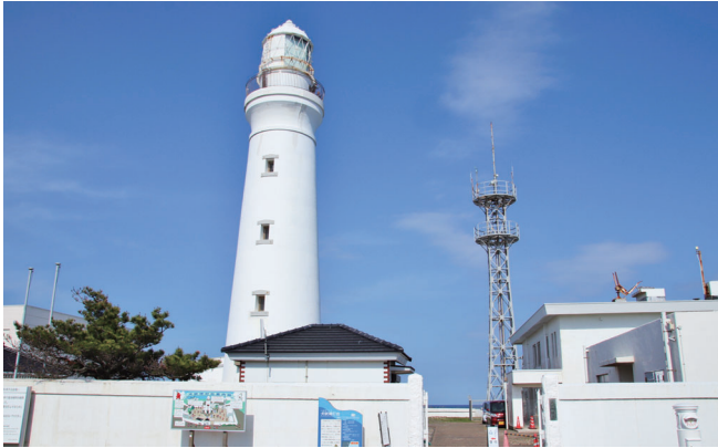
海洋施設 長寿命化対策
