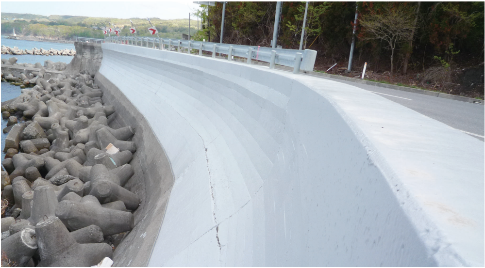
防波堤 長寿命化対策
