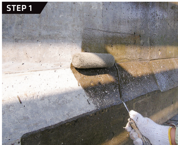
プライマー塗布
