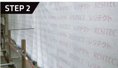
下地をトレースしながら 固定釘等により固定
