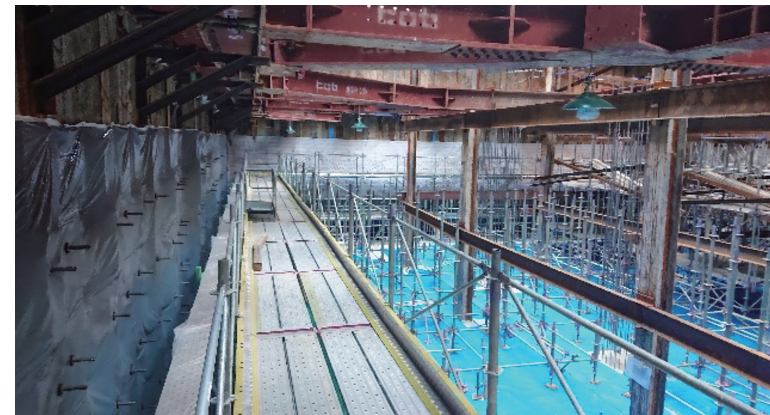
地下防水 側壁工事
