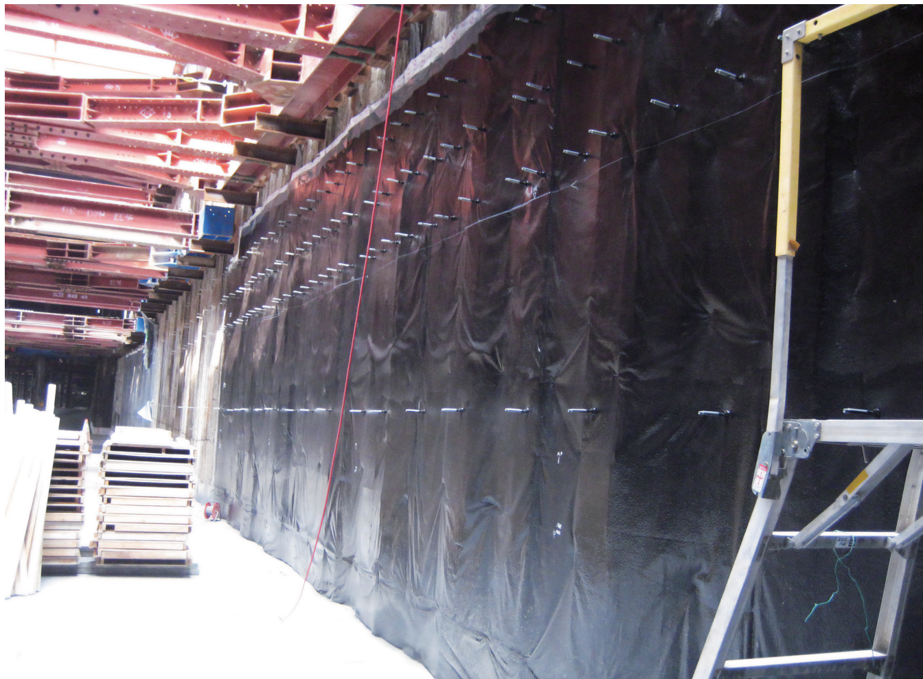
道路換気所工事
