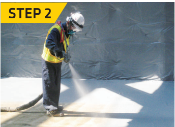
CVスプレーをコンクリートに 直接スプレー
