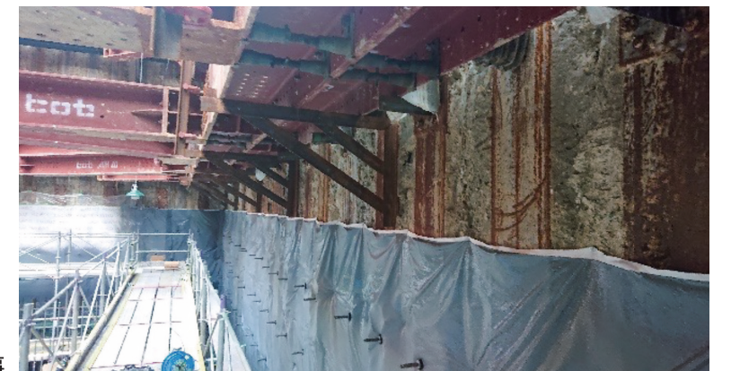
地下防水 側壁工事
