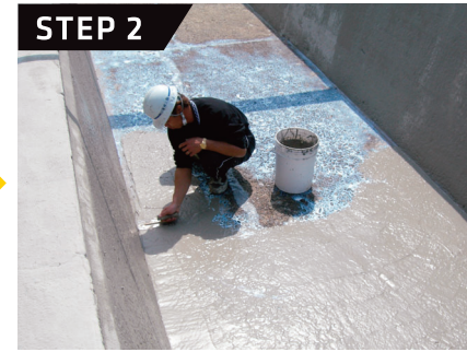
素地調整材塗布 ※オプション(下地状況により省く事が出来ます)
