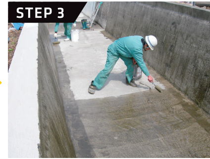
プライマー塗布
