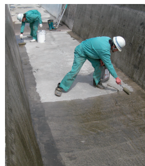
プライマー塗布
