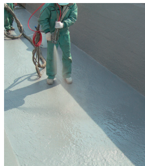
CVスプレー塗布工
