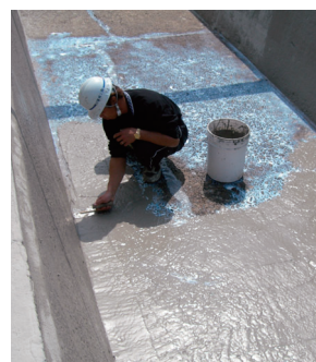
素地調整材塗布 ※オプション (下地状況により省く事が出来ます)
