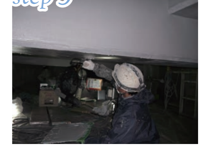
プライマー塗布
