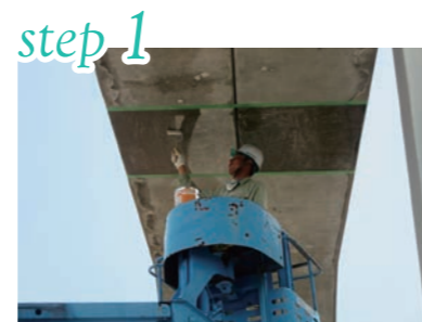
ワンガードクリアプライマー塗布
