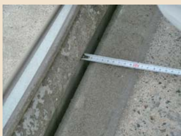
中央分離帯の遊間部分
