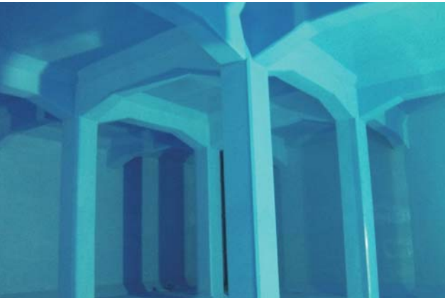
上水施設 (配水池)
