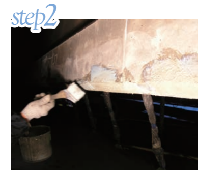
下地処理 (断面修復)
