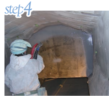
超速硬化ウレタン吹き付け
