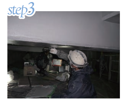
プライマー兼パテ塗布 (SAF・SBF) ※ SASC・SBSCはプライマーをローラー等で塗布となります。
