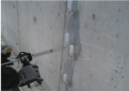
橋脚ひび割れ注入
