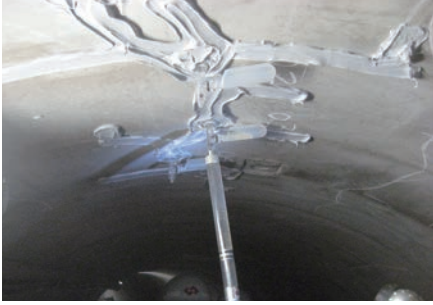
トンネル内壁ひび割れ注入
