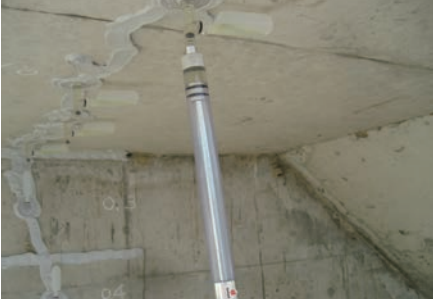
コンクリート打放し・上裏面
