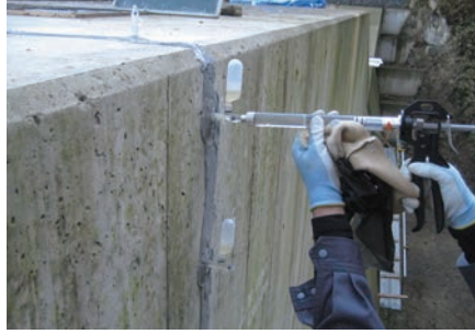
砂防堰堤ひび割れ注入
