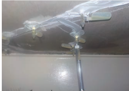
床版ひび割れ注入
