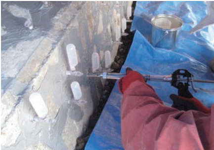
橋台ひび割れ注入
