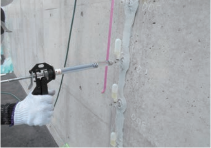
コンクリート打放し面
