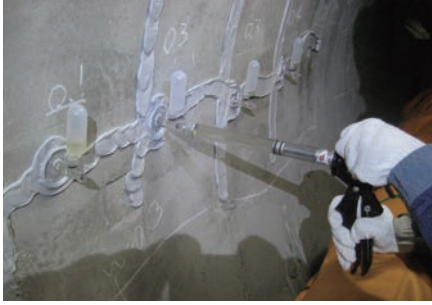
地下ビットひび割れ注入
