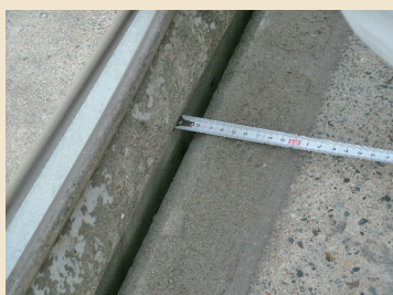
中央分離帯の遊間部分
