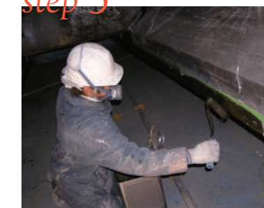
プライマー塗布
