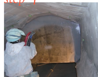
超速硬化ウレタン吹付け
