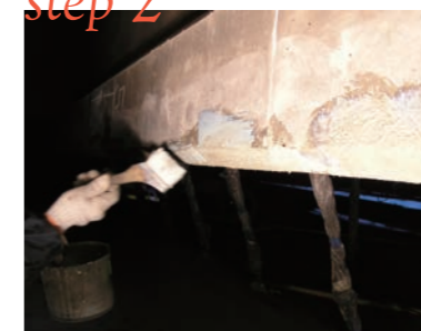
下地処理 (断面修復)
