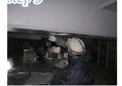
プライマー塗布
