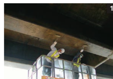
1 プライマー塗布
