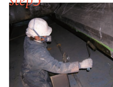
プライマー塗布
