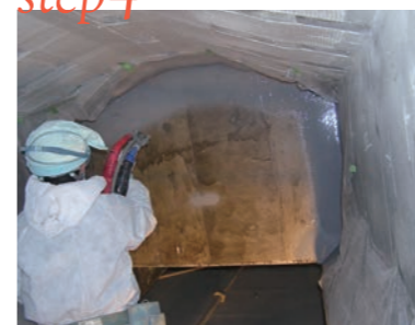
超速硬化ウレタン吹付け
