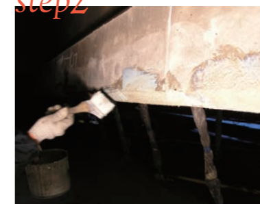
下地処理 (断面修復)
