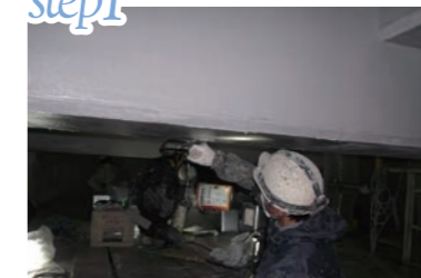
プライマー兼パテ塗布 (SAF・SBF) ※ SASC・SBSCはプライマーをローラー等で塗布となります。
