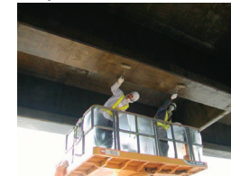
●プライマー塗布
